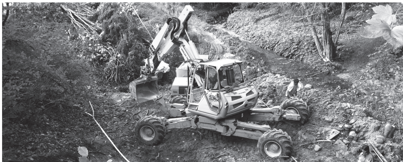
2011: Sanierung Quelffassungen Ettenberg
