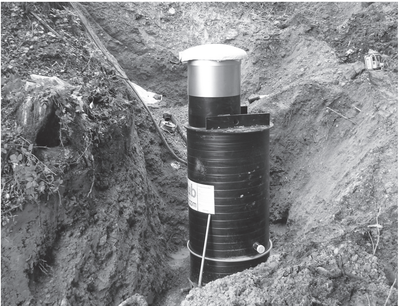
2006: Sanierung Quelfassungen Hinterberg
