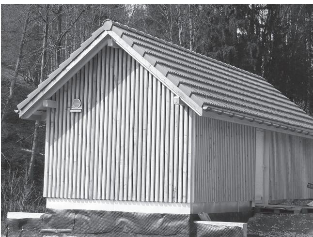
2013: Kernmühle Ultrafiltration Quellwasser.
